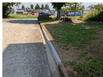
補修したブロック
